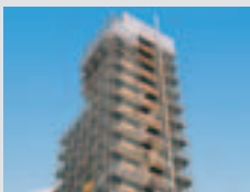
Rusztowania, schodnie, platformy robocze Rusztowania fasadowe Platformy robocze Dachy Schodnie
