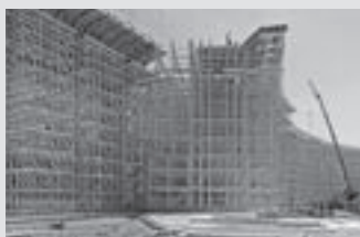
Rusztowania podporowe
