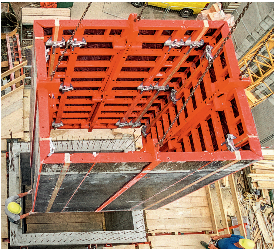
Prostokątne szyby windowe wymagają zawiesia z regulowaną długością cięgien. Pozwala to równomiernie obciążyć każde z nich.
