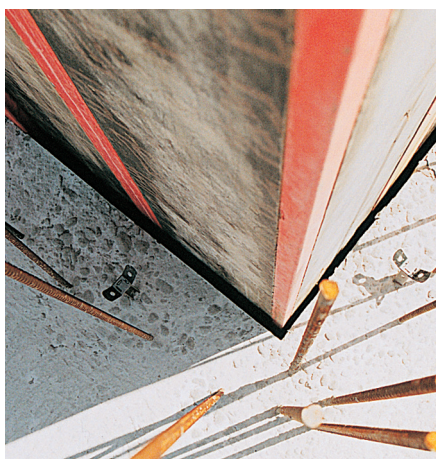
Luz o szerokości ok. 3 cm jest dobrze widoczny. Wstawka szybowa pozostaje blisko betonu jako prowadnica deskowania.
