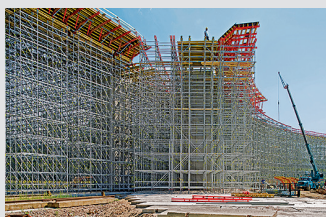
Rusztowania podporowe
