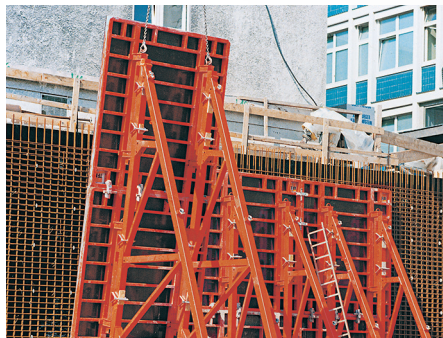
Połączenie kozłów umożliwia przenoszenie w postaci kompletnie zmontowanych konstrukcji oporowych.
