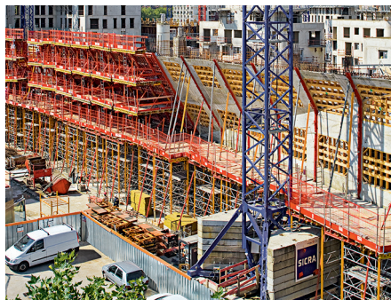
Budynek biurowy Boulogne-Billancourt, Francja
