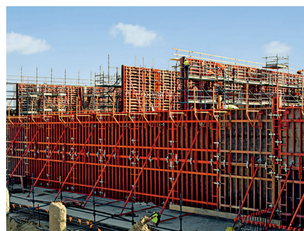
TRIO można nadstawić do wysokości 5,40 m w module co 30 cm. Przy większych wysokościach dodatkowo stosuje się rygiel wyrównawczy.
