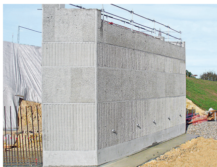
Na płytach TRIO Struktur można montować najróżniejsze płyty poszycia i dowolnie formować powierzchnię betonu.
