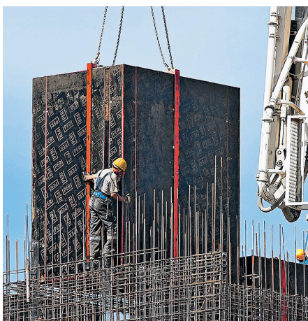
Przy podciąganiu wstawek szybowych do góry tworzy się ok. 3 cm luzu z każdej strony, co pozwala przestawić całą jednostkę deskowania jednym ruchem żurawia.
