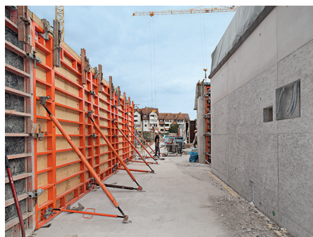
TRIO Struktur to wariant sprawdzonego deskowania ramowego, do którego pasuje cały osprzęt TRIO.
