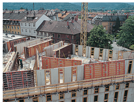
Płyty TRIO Struktur można łączyć ze standardowymi płytami TRIO. Jest to korzystne, gdyż specjalna faktura betonu jest zazwyczaj wymagana tylko z jednej strony.
