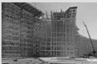
Rusztowania podporowe
