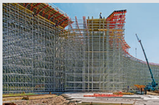
Rusztowania podporowe
