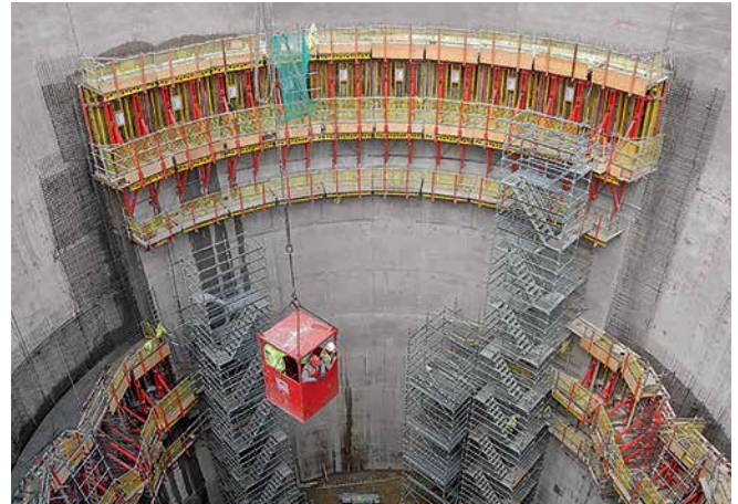
RUNDFLEX do wykonania szybu przepompowni o średnicy 25 m.
