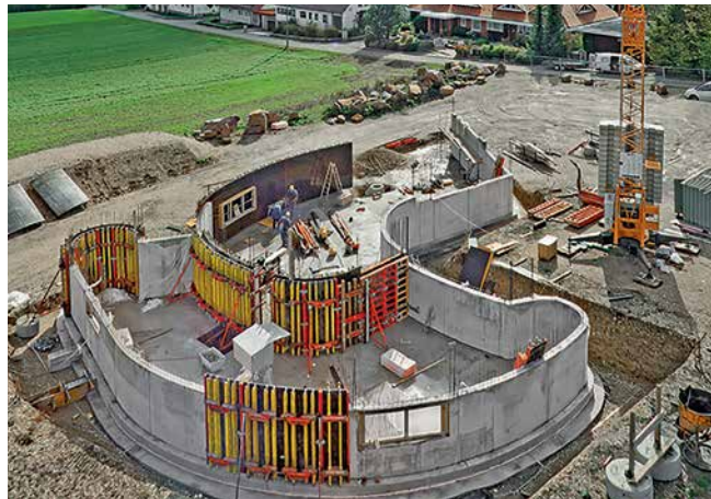
Niezwykle wyzwanie w budownictwie mieszkaniowym: żelbetowe ściany o zmiennych promieniach i poprzesuwane względem siebie stropy.
