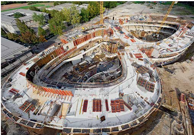
Wzorowe wykonanie łukowych betonowych ścian o zmiennych promieniach.
