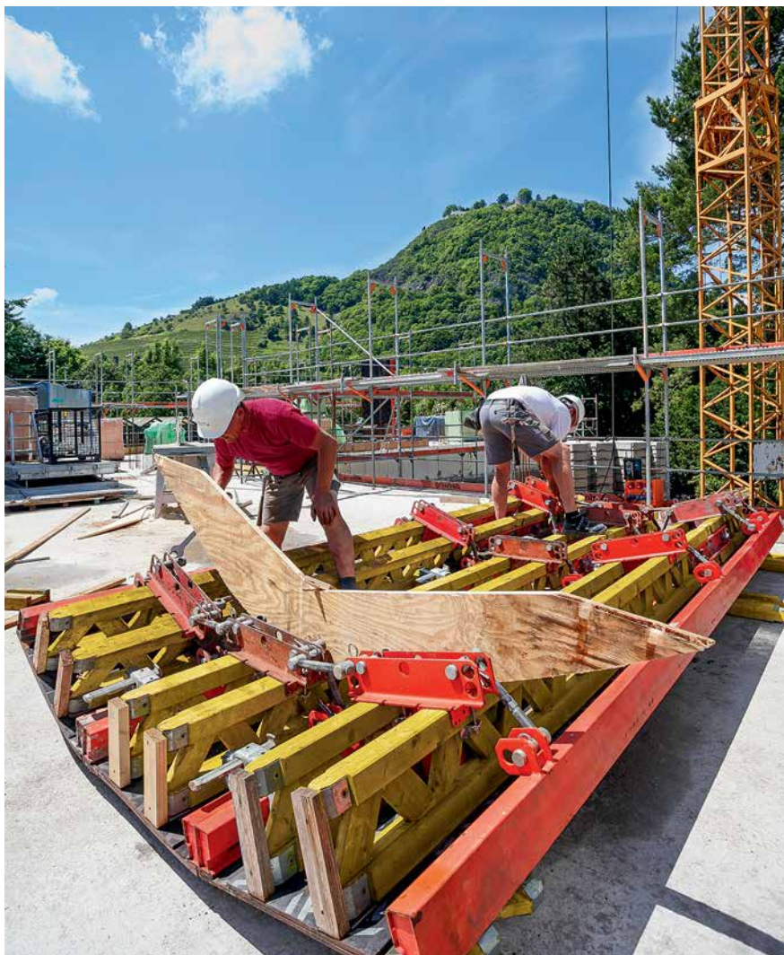
Kontrola krzywizny odbywa się przy pomocy szablonu przykładanego do dźwigarów deskowania.
