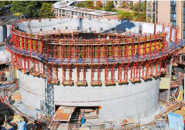
RUNDFLEX i beton architektoniczny: uzyskanie wysokiej jakości powierzchni betonu nie stanowi problemu.
