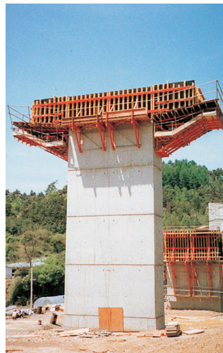
Kozły oporowe PERI SB-2 jako konstrukcja podporowa dla deskowania głowicy filarów.
