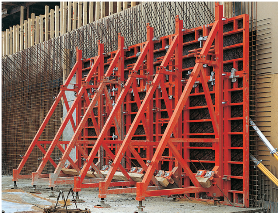
Kozły oporowe SB-B i C w połączeniu z deskowaniem ramowym TRIO, wysokość deskowania 3,90 m.
