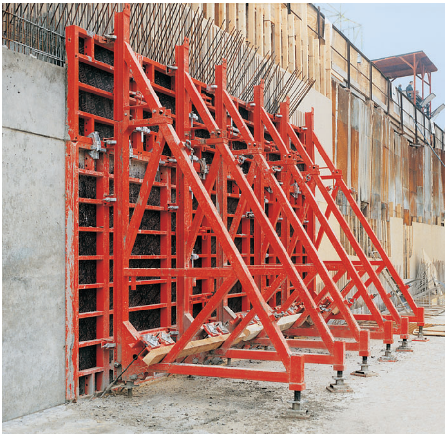
Konstrukcja oporowa SB-B i SB-C w połączeniu z deskowaniem ramowym PERI TRIO, wysokość betonowania 3,50 m.
